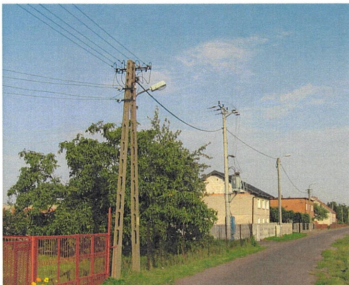
Fot. 5. Linie dystrybucyjne nn-0,4 kV (przykłady)
